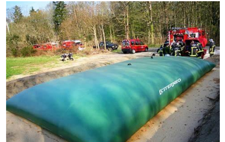
Réserve d'eau souple permettant l'intervention du SDIS
